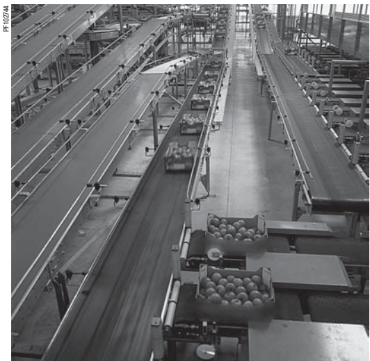
Управление фасовочным оборудованием
